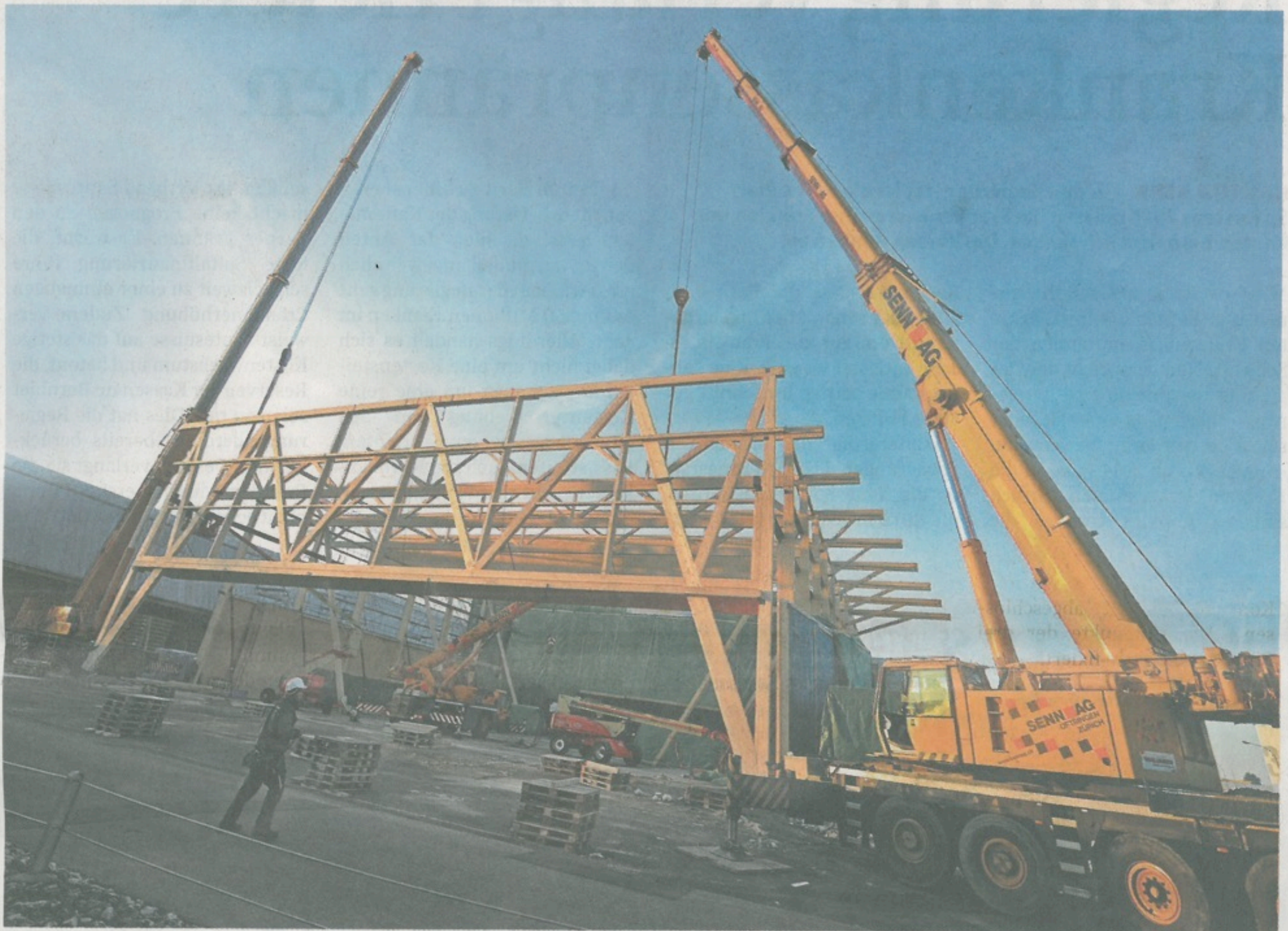
Riesige Konstruktion: Die beiden Autokräne richten das über 20 Tonnen schwere Dachteil des neuen Hector-Egger-Werks auf.
